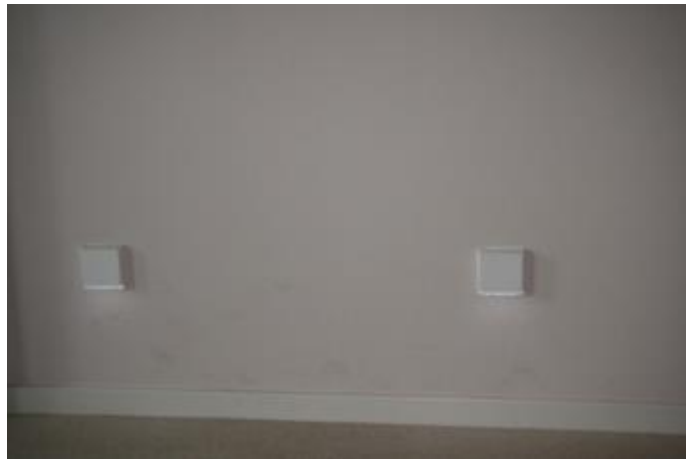
Afbeelding 7: Routeverlichting naar toilet
